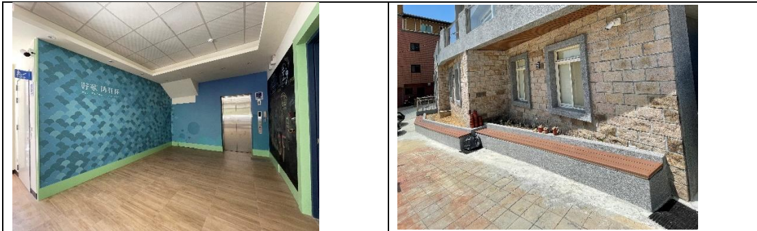
一樓天花板室修工程 拍攝日期：2023 年 8 月 24 日
