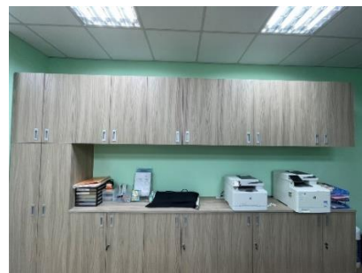
一樓辦公室高櫃木作工程 拍攝日期：2023年8月24日
