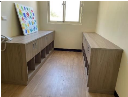
三樓走道矮櫃木作工程 拍攝日期：2023年8月24日
