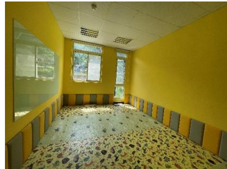
三樓早療教室防護地墊、壁貼、油漆 拍攝日期：2023年7月29日
