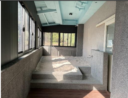
二樓沙坑裝修工程 拍攝日期：2023年8月24日
